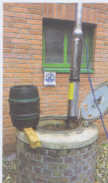
Der letzte Arbeitsschritt vor der Wiederinbetriebnahme: Einfahren der Pumpe mit Steigrohr in den Brunnen.
