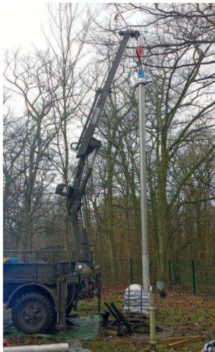
Das linke Bild zeigt die Hochdruckkinnenspülung. Das rechte Bild dokumentiert, wie ein Steigrohr ausgetauscht wird.
